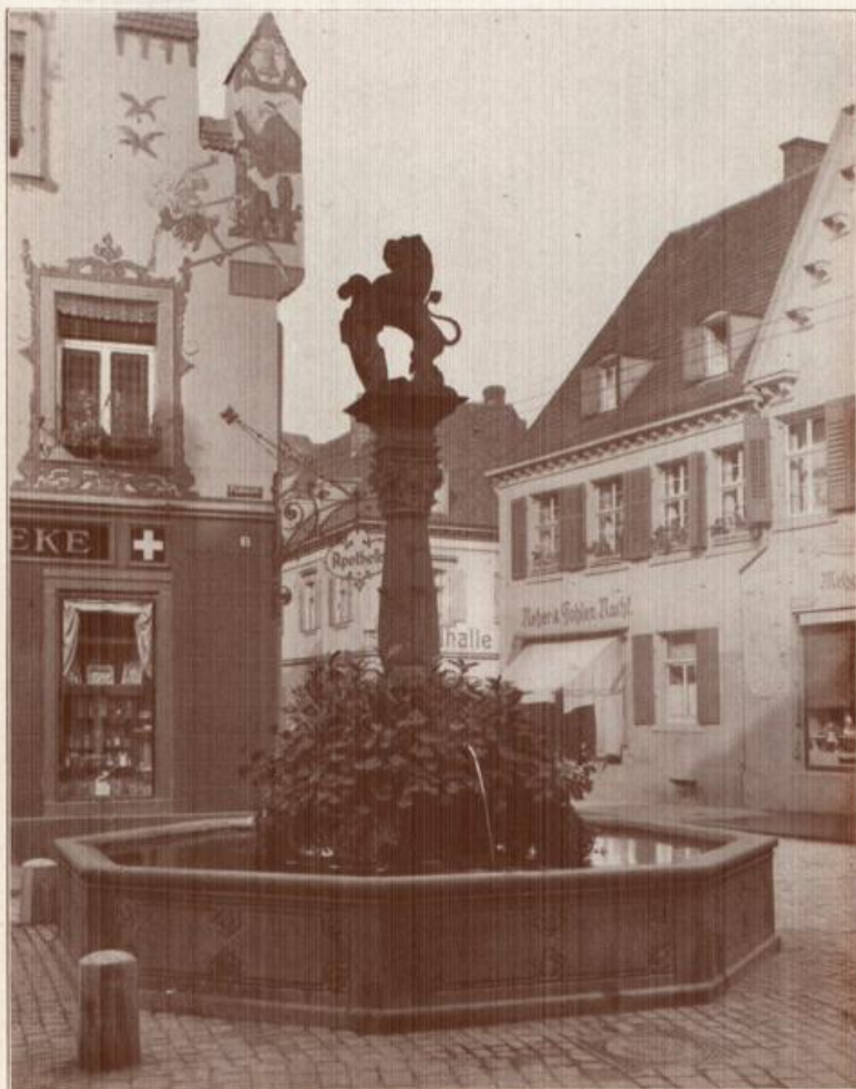
Offenburg, die Verkehrszentrale Mittelbadens.
