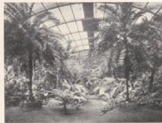
PALMENHAUS IM PALMENGARTEN
