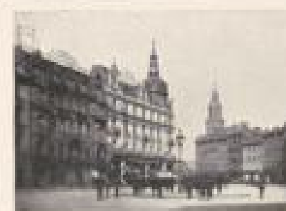
KAISERPLATZ BAHNHOF, QUERPERRON BAHNHOF-FASSADE BAHNHOF, MITTELHALLE ROSSMARKT
