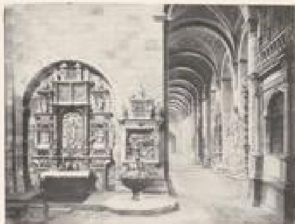
INNERES DES DOMS (NORDSEITEL, MAINZ)
