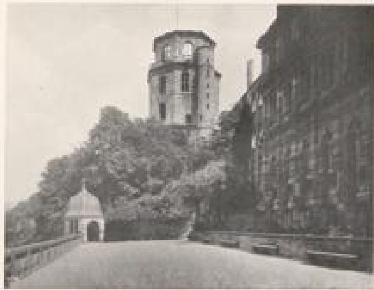
DER ACHTECKIGE TURM MIT DEM ALTAR
