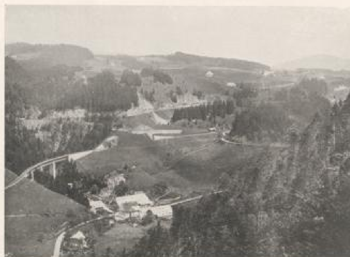
PARTIE DER HÖLLSTALBAHN BEIM GASTHAUS ZUM STERN
