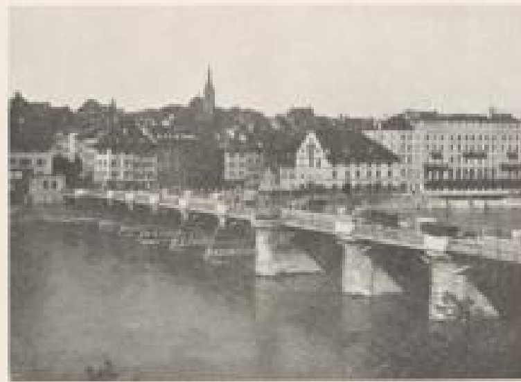
ALTE WEIDENBRÜCKE IN BASEL
