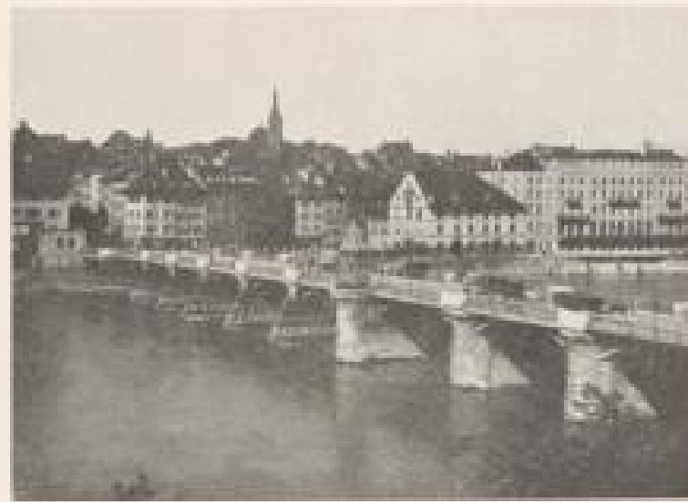
ALTE WEIDENBRÜCKE IN BASEL
