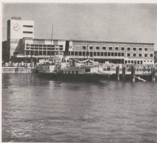
Friedrichshafen s/ Lago di Costanza, la nuova Stazione del Lago
