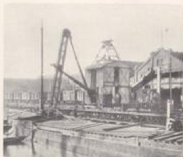
ELEVATOR UND VERBINDUNGSKANAL, MANNHEIM
