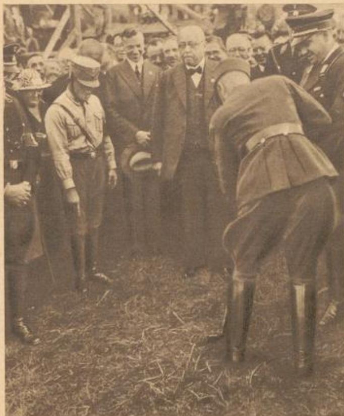
Der badische Ministerpräsident Köhler führt den ersten Spatenstich zum Bau der Rheinbrücke aus
