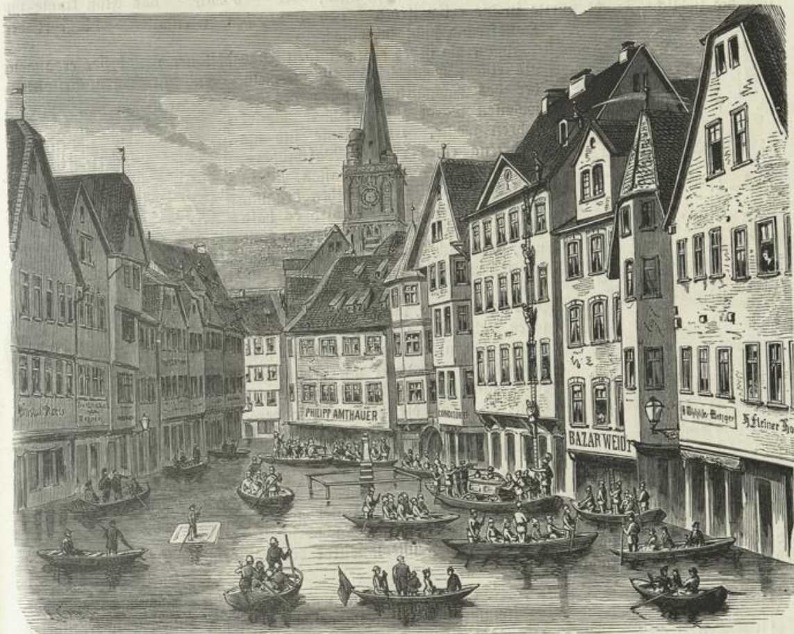
Feuerwehrrübung auf dem Marktplatz in Wehrheim bei Hochwasser.
