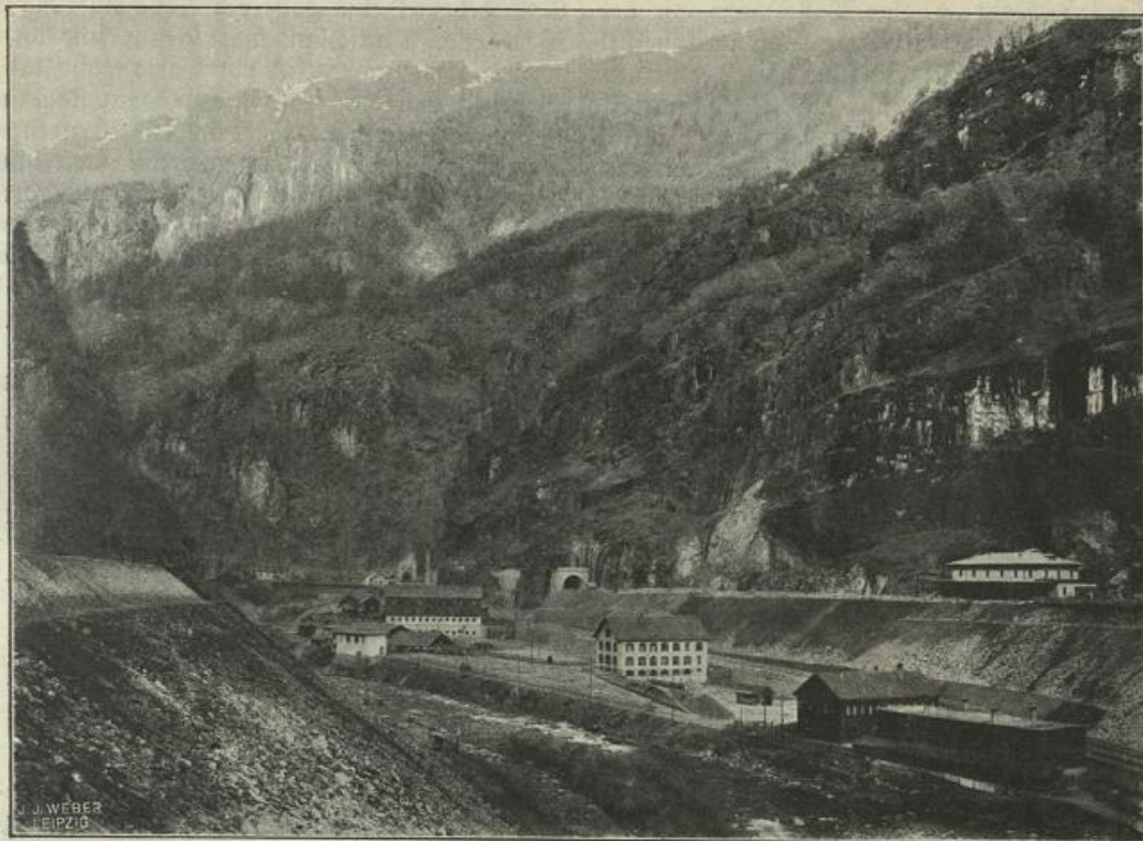
Südseite des Simplontunnels: Ausmündung bei Iselle.
