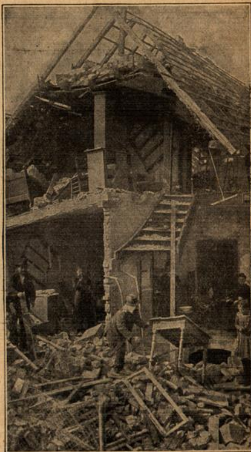
Sur Explosionskatastrophe in Oypau. In der Mitte gespaltenes Haus.
