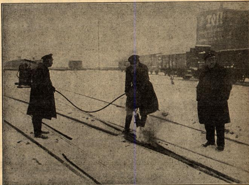
Mit Flammentwerfern gegen eingefrorene Weichen.
