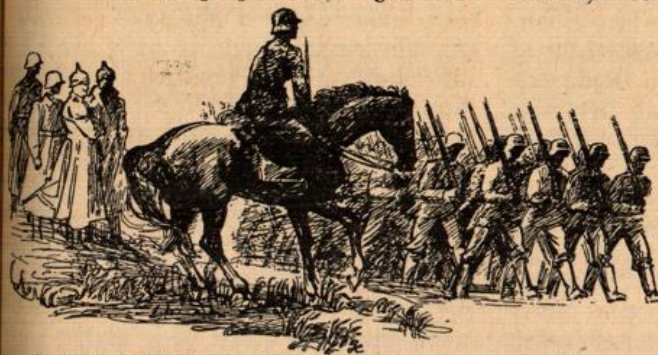
Dem Leutnant Meyer wurde befohlen, die 14. Kompanie vorzuführen.
