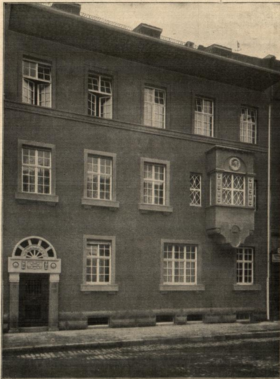
Hauseingang in Keramik, Entwurf Architekten Pfeifer & Großmann, Karlsruhe, Ausführung Großh. Manufaktur, Karlsruhe.
