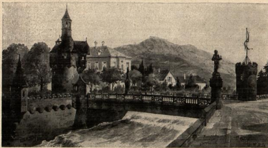
Die Schwabentorbrücke in Freiburg im Breisgau.
