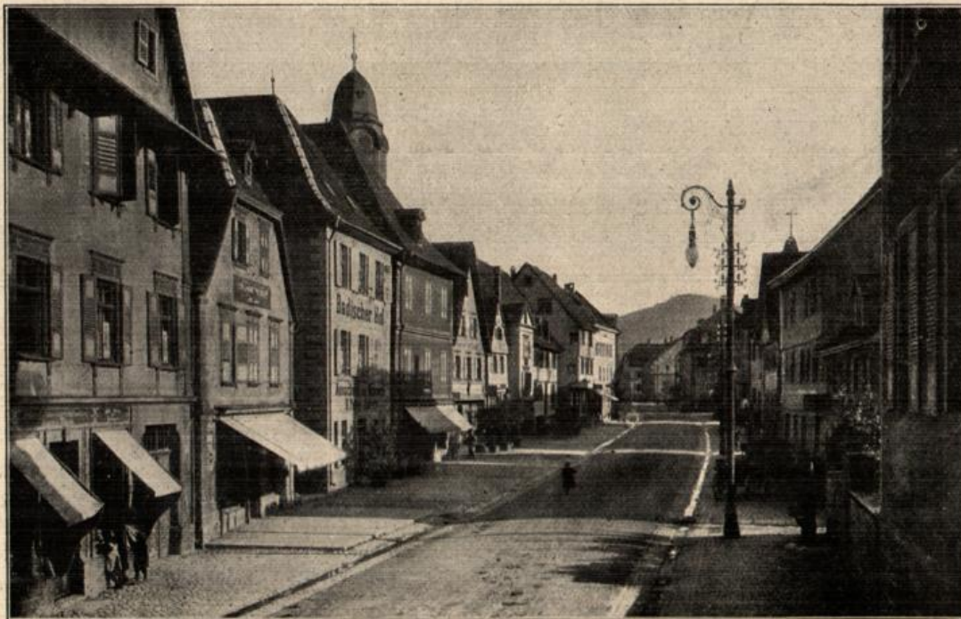
Die Hauptstrasse von Oberkirch.
