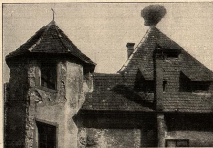
Ein alter Hausbau in Oberkirch.
