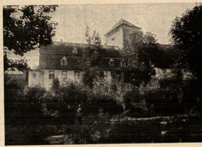
Anlagen am oberen Tor in Villingen.
