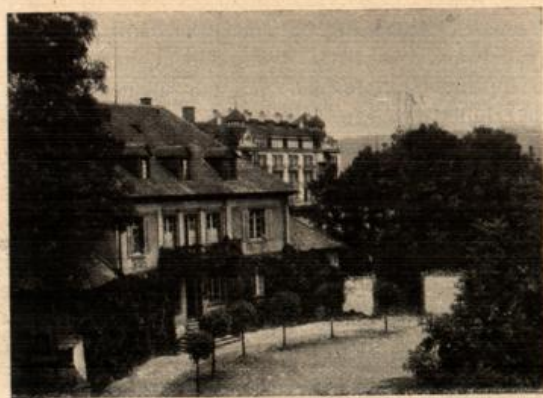
Verwaltungsgebäude der Grossh. Saline zu Dürrheim.
