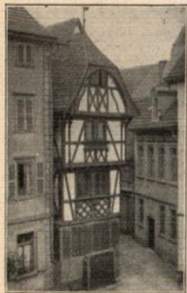
Restauriertes Giebelhaus des 16. Jahrhunderts am alten Markt zu Eberbach.
