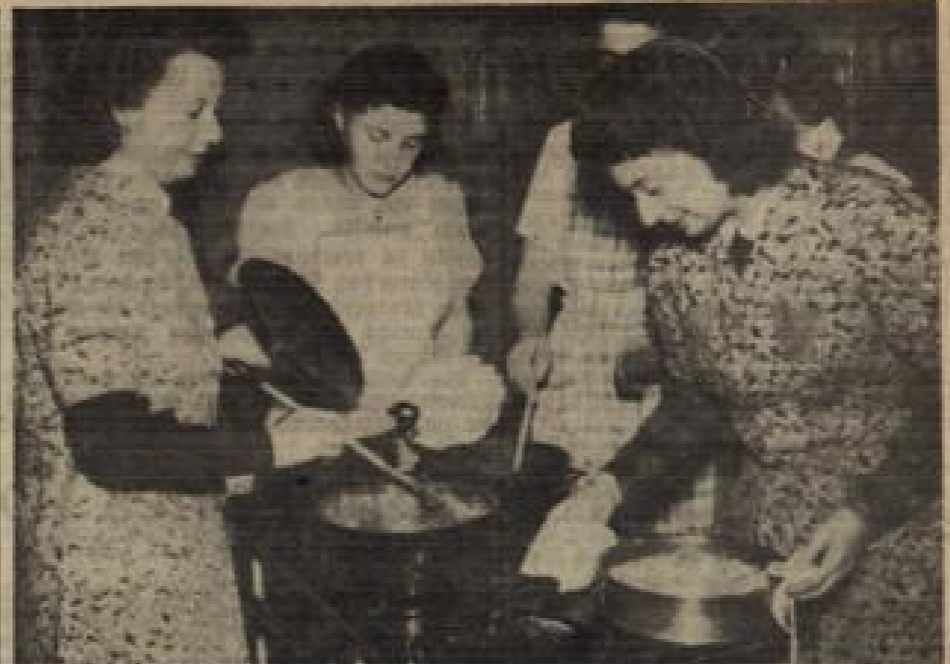
BDM-Work-Mittel in „leerer“ Küche im Keller der Adelhausestraße in Freiburg
