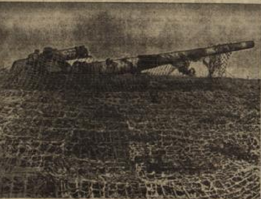
Links: Bei einer Batterie der Heeres-Elektroartillerie an der Kaszibela. Bei Agram wird das Rohr hochgedreht und schreit wieder das Geschütz (oben) herbei. Die Turmung ist immer noch wirksam. - Rechts: Ein amerikanischer Soldat der in dem Kampf bei Salerno in deutsche Gefangenschaft kam...
