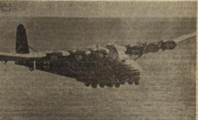
Me 323, das größte Landflugzeug der Welt. Der „Gigant“ ist ein von dem Messerschmitt-Werke geschaffenes sechsmotoriges Gütertransportflugzeug, das von der deutschen Luftwaffe seit längerer Zeit eingesetzt ist und sich bereits bei mehreren Operationen ausserordentlich als Transporter, besonders für weite Strecken, bewährt hat.
