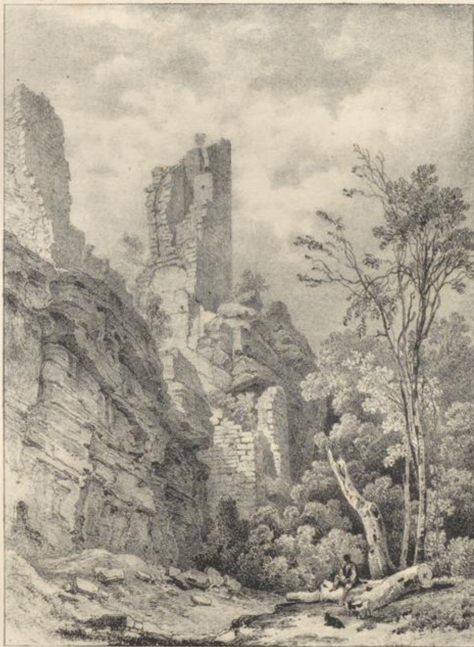
Intérieur d'un des passages de Lutzelhard.
