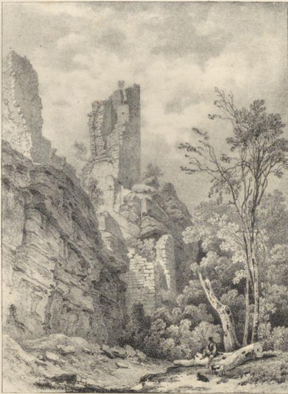
Intérieur d'un des passages de Lutzelhard.
