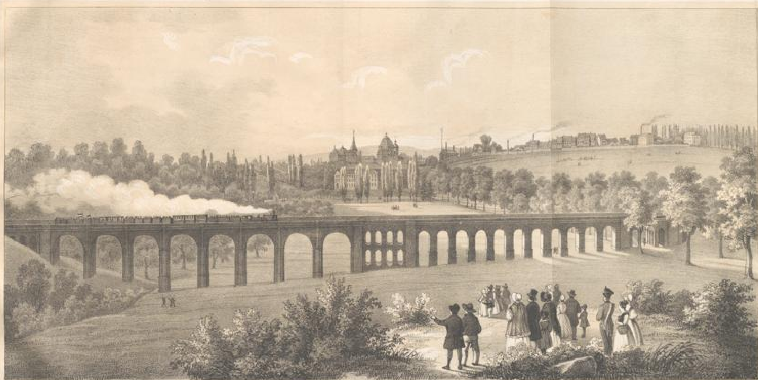
EISENBAHN VIADUCT BEI BURTSCHIED
