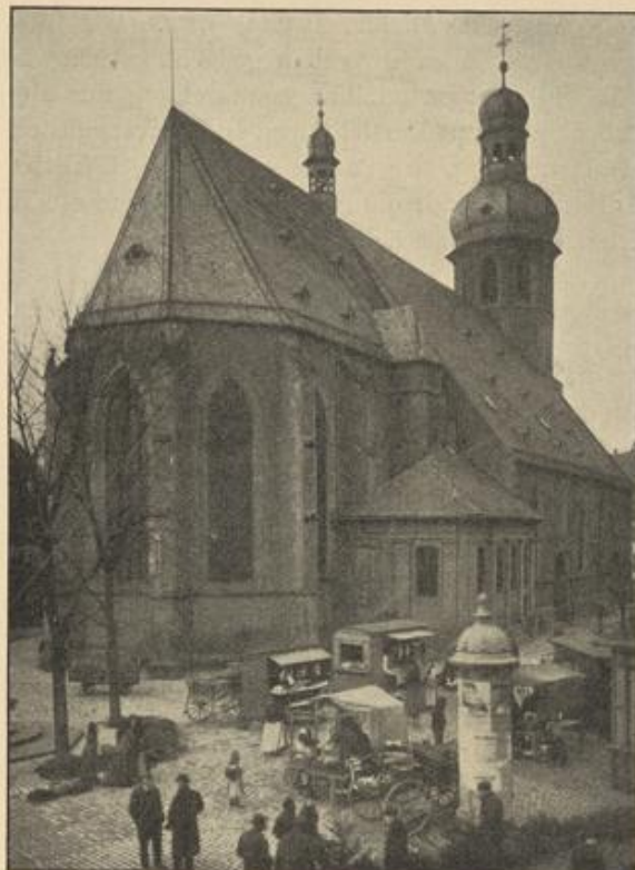
Abbildung 71. Äußeres der Liebfrauenkirche.
