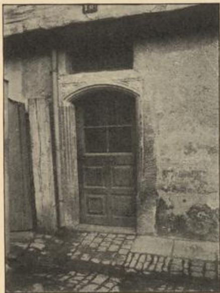
Abbildung 11. Doppelwohnhaus Rathausstraße 9. Portal c. 1570.
