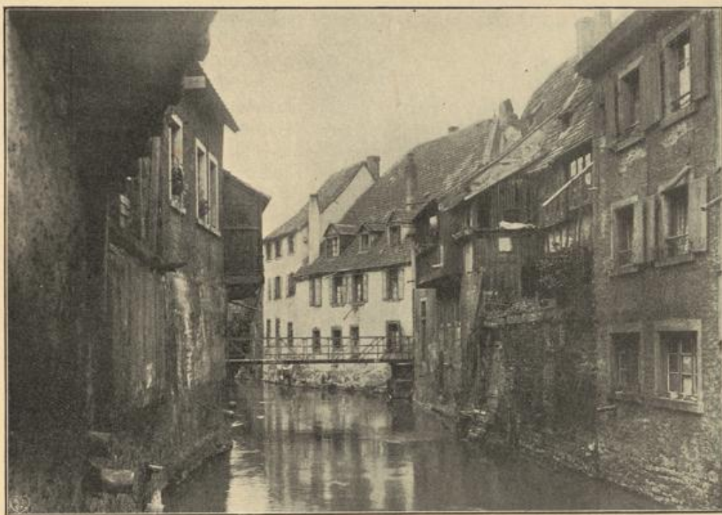
Abbildung 61. An der «Haffnenbrücke» (Badsteg).
