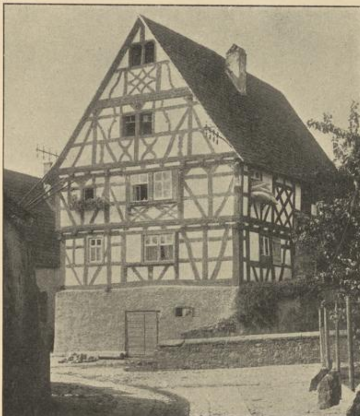
Abbildung 14. Haus aus Malsch c. 1690. Beispiel der fränkischen Holzbaukunst des Bruhrains.
