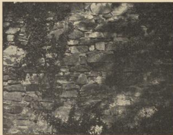
Abbildung 2. Bruchsteinmauer aus Keupersandstein. Rothenberg c. 1400.
