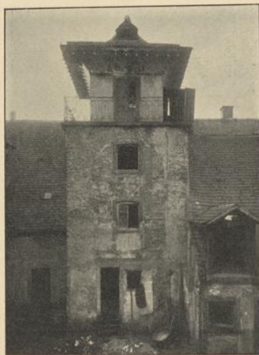
Abbildung 81. Mauerturm an der Zwerchstraße.
