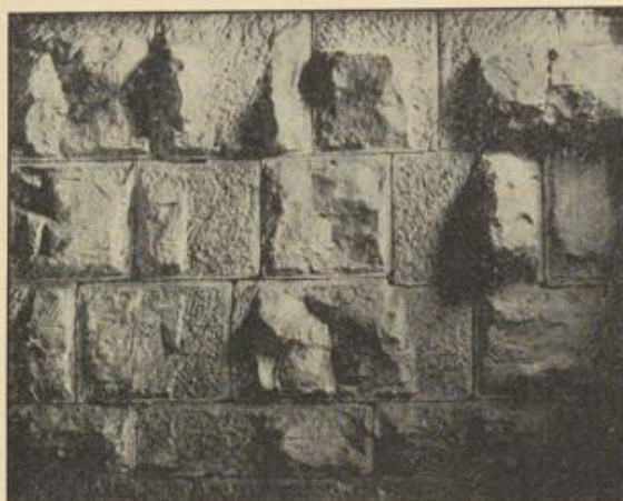
Abbildung 1. Quadermauer vom Burgturm zu Kislau. c. 1200.
