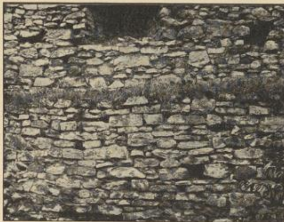
Abbildung 3. Bruchsteinmauer aus Muschelkalk. Bruchsal c. 1400.
