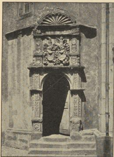
Abbildung 48. Portal des Hoheneggerhofes zu Bruchsal 1552.
