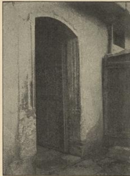
Abbildung 12. Doppelwohnhaus Rathausstraße 9. Portal c. 1570.
