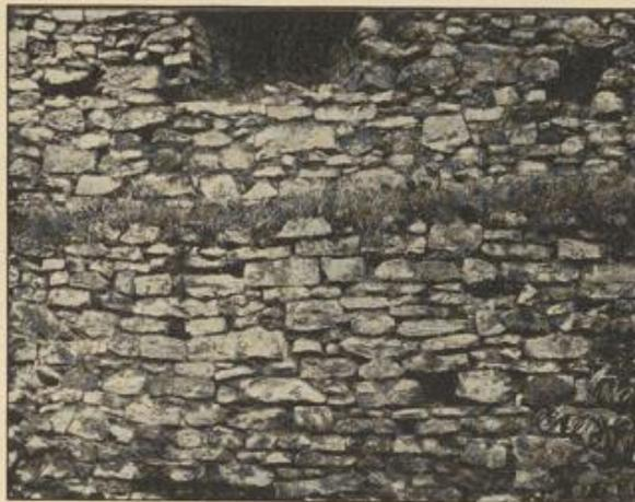
Abbildung 3. Bruchsteinmauer aus Muschelkalk.
