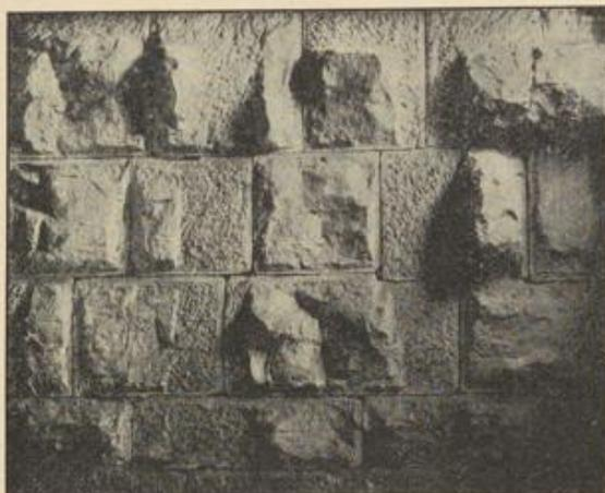
Abbildung 1. Quadermauer vom Burgturm zu Kifflau. c. 1200.
