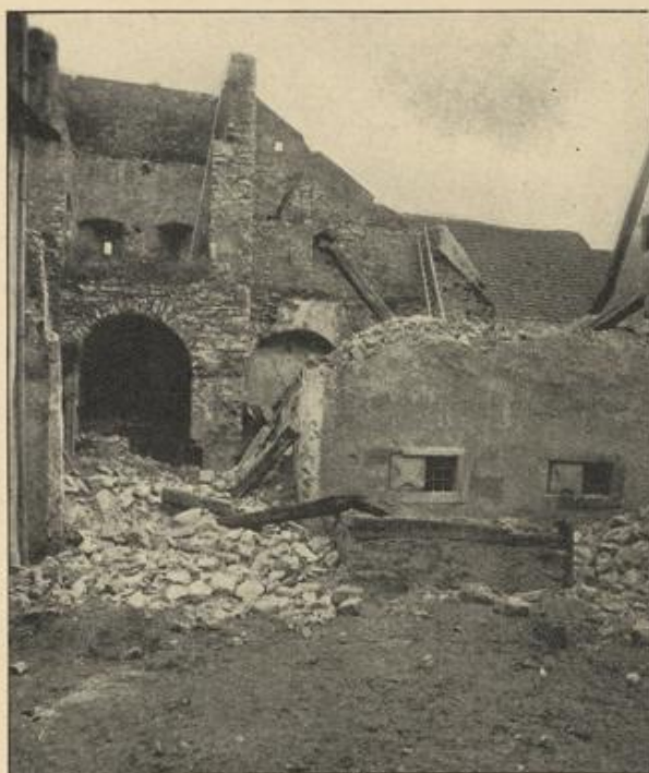
Abbildung 82. «Wachhaus» am Durchfluß des Krottbachs durch die Ringmauer.
