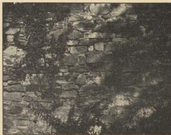
Abbildung 2. Bruchsteinmauer aus Keupersandstein. Rothenberg c. 1400.
