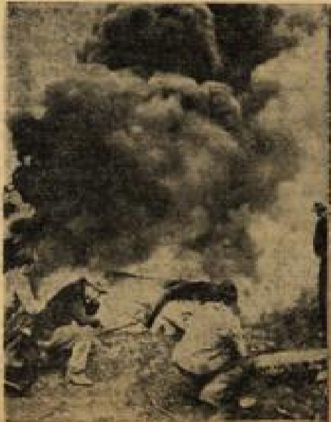
Demontage bis unter die Erde Auf dem Gelände der Krupp'schen Gußstahlfabrik wurden auch die unterirdischen Ruhr-Gasleitungen gesprengt.
