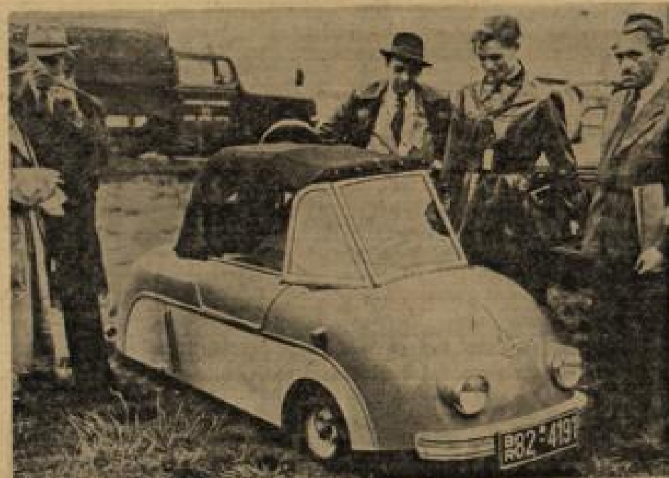
„Wiesel“, der kleinste Kleinwagen — der überall Aufsehen erregte Er kostet 2000 DM und erreicht eine Spitzengeschwindigkeit von 85 Stundenkilometern bei einem Brennstoffverbrauch von 3,5 Litern auf 100 Kilometer
