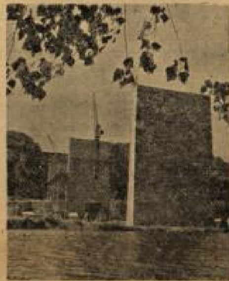
Eine der höchsten Brücken Deutschlands entsteht zwischen Kassel und Göttingen über die Werra. Die Pfeiler der Reichsautobahnbrücke sind schon fast fertig und in Kürze kann die Brückenkonstruktion aufgelegt werden.
