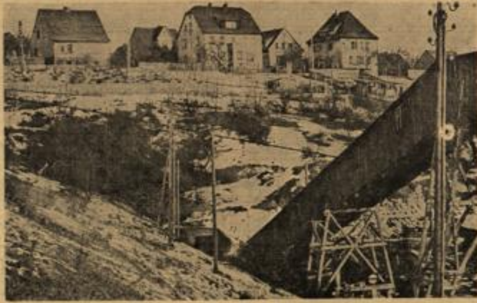
32 Wohnhäuser sollen der Kohle weichen In Großenenglis (Hessen) sollen 32 Häuser abgerissen werden, weil unter ihnen ein ergiebiger Kohlenfeld entdeckt wurde, das im Tagebau ausgebeutet werden soll
