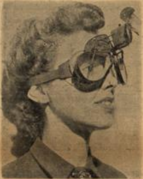
Motorradbrille mit Scheibenwischer Ein kleiner Propeller, durch den Fahrtwind in Bewegung gesetzt, betätigt die Wischer
