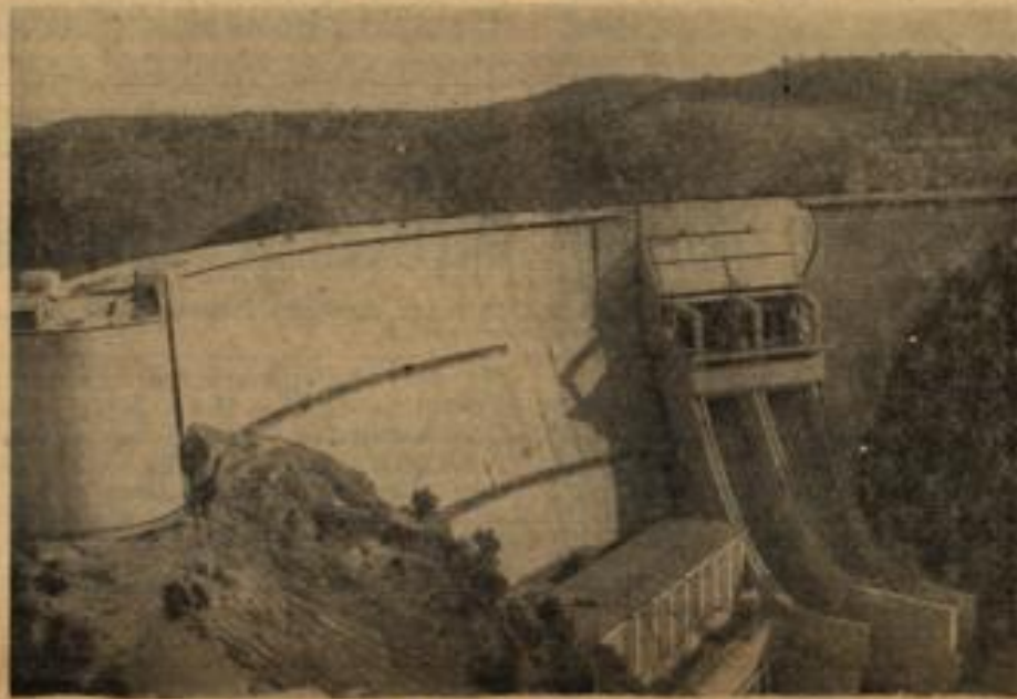
Portugals erstes großes Elektrizitätswerk eingeweiht Kürzlich wurde das erste große Elektrizitätswerk Portugals an der neuerrichteten Talperre von Castelo Bode in Betrieb gesetzt. Mit dieser Talperre, deren Sperrmauer 120 Meter hochragt, besitzt das Land eine Energiequelle von jährlich 300 Millionen Kilowatt Strom
