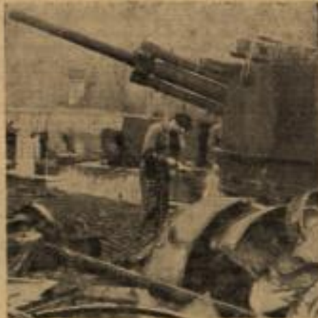
Das Ende der Donau-Flottille Die Reste der seit Kriegsende im Passauer Hafen liegenden königlich-ungarischen Donau-Flottille werden jetzt verschrottet. Schwachföhren zerlegen die Panzertürme der Kanonenboote
