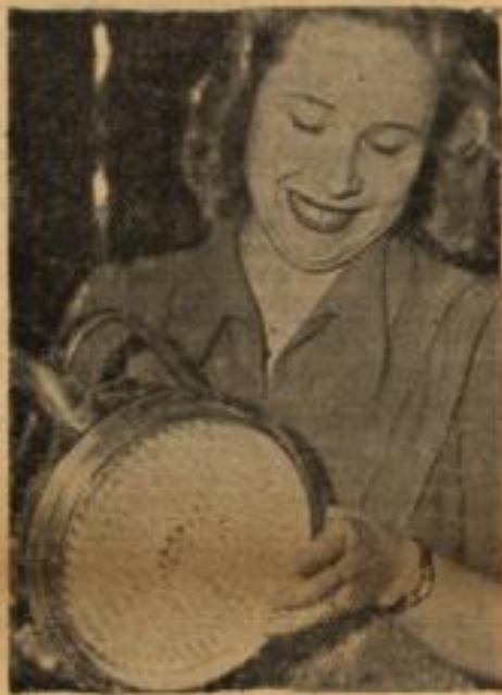
Der Zapfentopf spart Zeit und Gas, denn er hat einen Boden aus einer Menge kleiner Zapfchen, die mehr Hitze aufnehmen
