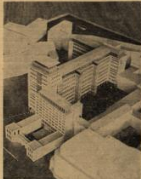
Eines der modernsten Fernmeldeämter Europas entsteht in Frankfurt am Main, dem Schnittpunkt des deutschen Kabelnetzes
