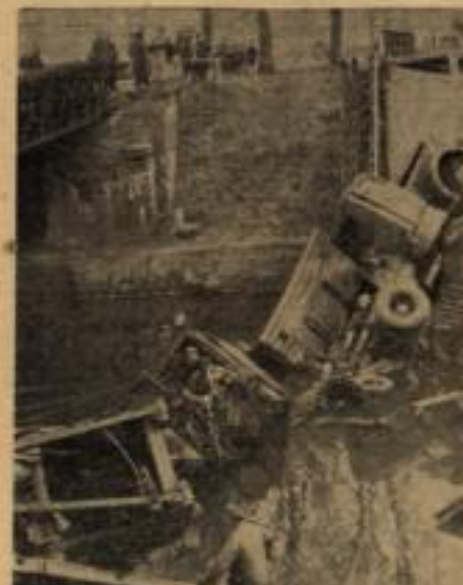
Nur geringfügig verletzt wurden die Insassen dieses Lkw, unter dem eine Notbrücke zusammenbrach
