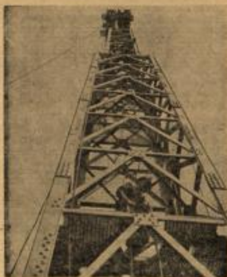
Auf dem höchsten Gebäude der Welt dem 350 m hohen Empire-State-Building in New York wurde ein Fernseh-Sendemast von 65 m Höhe errichtet. Die Kosten dieses Sendemastes betragen 1 000 000 Dollar
