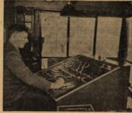
Fernsteuerung vom Stellwerk aus
