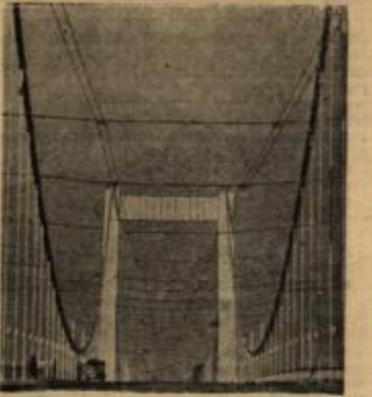
Die modernste Hängebrücke Europas wurde in Köln von Bundeskanzler Adenauer dem Verkehr übergeben. Die neue Brücke verbindet die Städte Mülheim und Köln. Sie ist 183 Meter lang, 27 Meter breit und überbrückt mit 350 Meter Spannweite den Rhein
