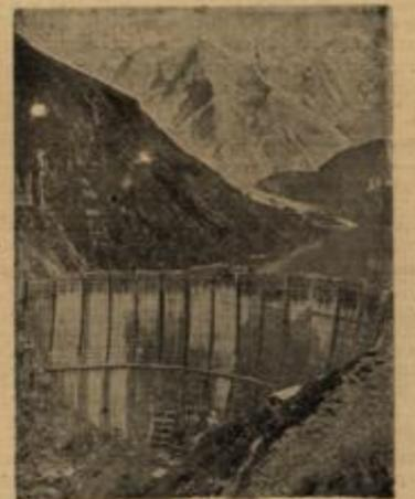
Die Sperrmauer des Tauerkraftwerkes deren Bau vor etwa drei Jahren begonnen wurde, ist nun fertiggestellt. Das Kraftwerk wird zu den größten bisher in Europa erbauten Anlagen dieser Art zählen. Der Staudamm hat eine Höhe von 120 m und ist am Fuß 48 m und an der Krone 7 m stark.
