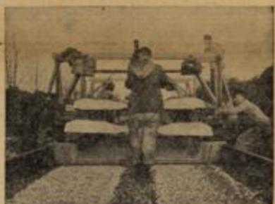
auf sehr stark belasteten Strecken, auf denen längere Gleissperrungen unmöglich sind, nicht einbauen. Bei den Stahlbetonschwellen der Deutschen Bundesbahn handelt es sich um sogenannten Spannbeton, d.h. um einen Beton, bei dem die Stahleinlagen eine starke Zug-Vorspannung erhalten und dadurch den Beton unter eine entsprechende Druckspannung versetzen.
