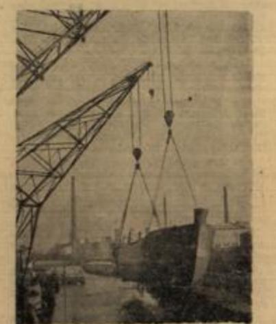
Ein Schiff wird aus der Wiege gehoben
