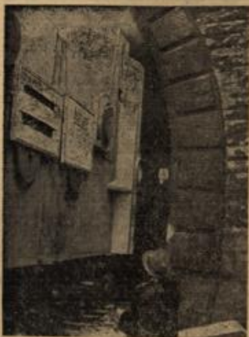
Beinahe streift der 59 Tonnen schwere Stahlkolob die Tunnelwand
