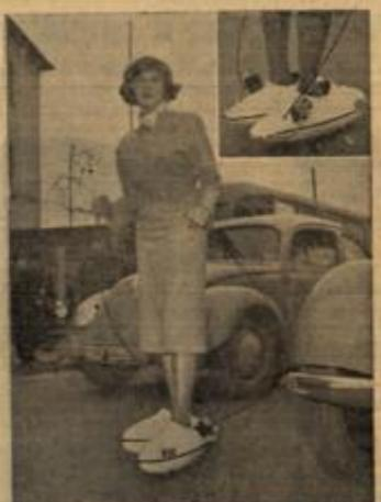
**Der Kampf um den letzten Fußgänger hat begonnen!** Bei NSU setzte in diesen Tagen die Serienfertigung der NSU-Dalli-Rollschuhe ein, die man im doppelten Sinn des Wortes als fortschrittlich bezeichnen kann. In jedem Schuh befindet sich ein kleiner 24 cm-NSU-Zweimotormotor, dessen schwimmerloser Vergaser durch Handhebel in Gürtelhöhe über Bowdenzug gesteuert wird. Die NSU-Dalli-Schuhe sind steuer- und fährerscheinfrei. Das Preis beträgt DM 158.—.
