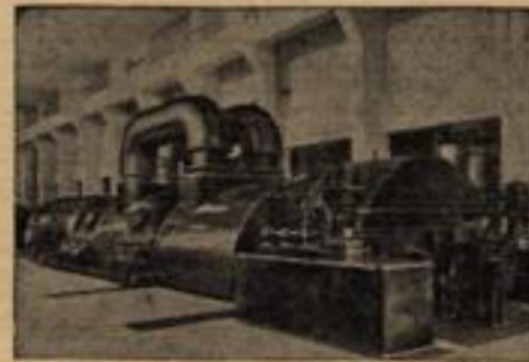
Der fünfte und größte Turbo-Generatorsatz des Dampfkraftwerkes Marbach a. N. erzeugt 50 000 kW
