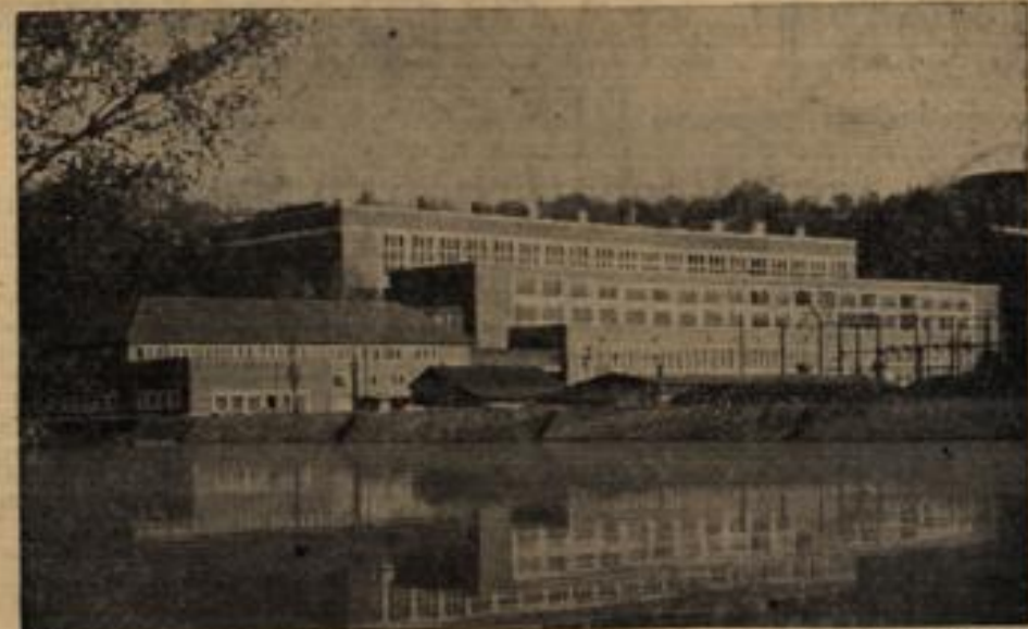
Das Dampfkraftwerk Marbach der Energie-Versorgung Schwaben (EVS) ist mit einer Leistungskapazität von 212 000 kW nunmehr voll ausgebaut. Unser Bild zeigt den modernen Komplex am Neckarufer
