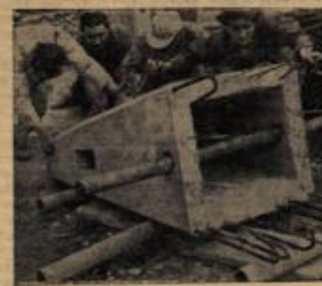
Die Fahrbalke der Hochschnellbahn Unser Bild zeigt Arbeiter bei der Errichtung des Beton-Bahnkörpers für die Versuchsstrecke, auf der Modellversuche der Hochschnellbahn durchgeführt werden sollen.
