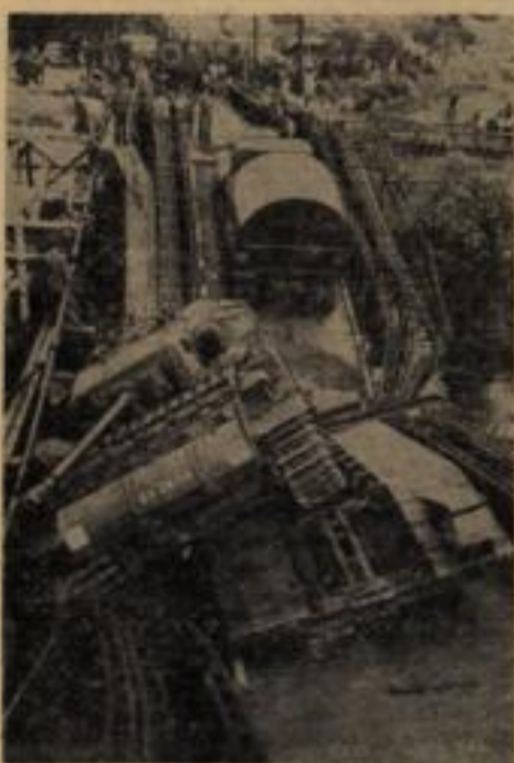
Brücke brach unter der Last eines Panzers Die Bailey-Behelfsbrücke über die Wümme bei Rotenburg (Niederrhein) brach unter einem britischen Lastzug, der einen Sechzig-Tonnen-Panzer geladen hatte, zusammen
